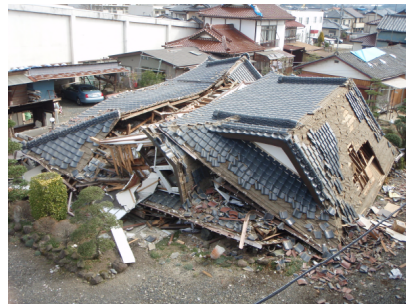
写真 揺れによる建物被害 (常陸太田市・東日本大震災)
