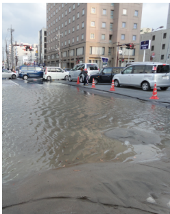
写真 道路の液状化 (水戸市・東日本大震災)
