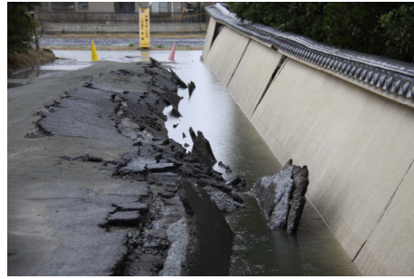
写真 液状化被害（ともに潮来市・東日本大震災）
