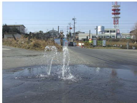
写真左 水道管の破裂、写真右 落石による電柱被害 (ともに石岡市・東日本大震災)
