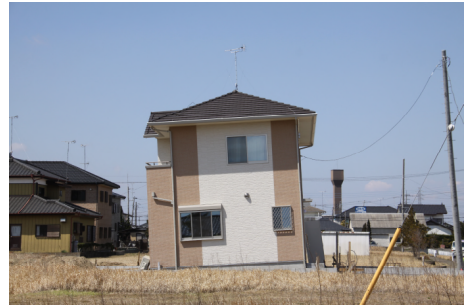
写真 液状化被害（ともに潮来市・東日本大震災）
