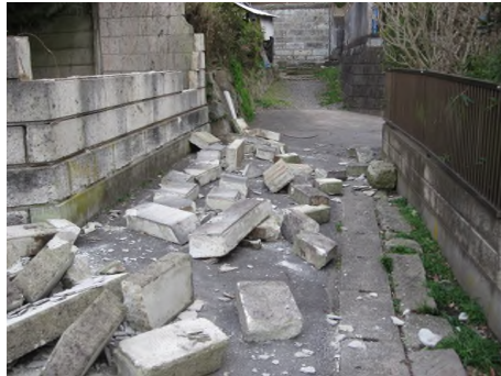
写真 ブロック塀の倒壊の様子（左：石岡市、右：笠間市・ともに東日本大震災）
