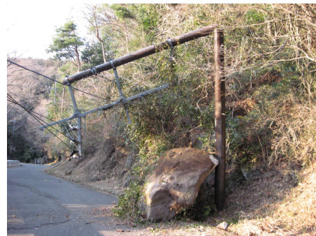
写真左 水道管の破裂、写真右 落石による電柱被害 (ともに石岡市・東日本大震災)
