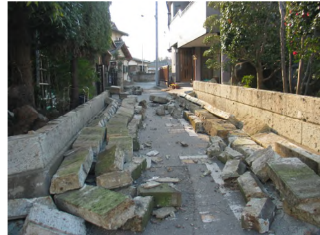
写真 ブロック塀の倒壊の様子（左：石岡市、右：笠間市・ともに東日本大震災）
