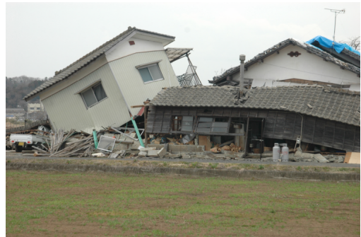
写真 揺れによる建物被害 (ともに常陸太田市・東日本大震災)
