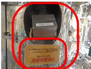
②ノズル取付け口へ閉止キャップ取付け、施錠及び手動弁を閉の状態に施錠。
