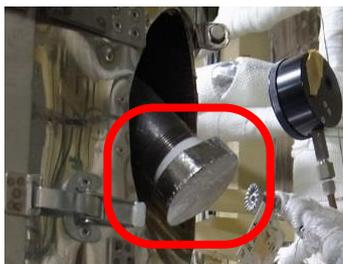
①脱硝塔から左右ノズルを取外し。
