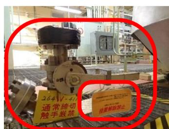
④種用ウラン粉末の供給ラインの手動弁(264W411)を閉の状態に施錠。
