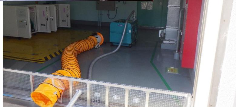
火山灰の降灰時における可搬型発電機の排気対策
