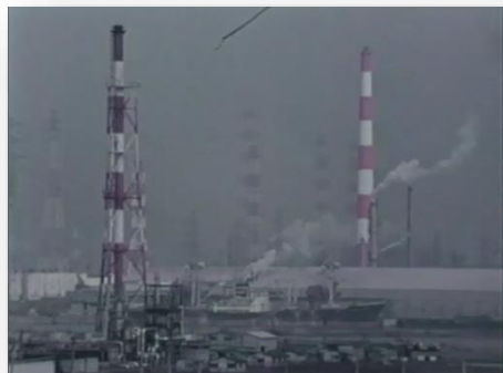
白煙吹き上げる鹿島臨海工業地帯
