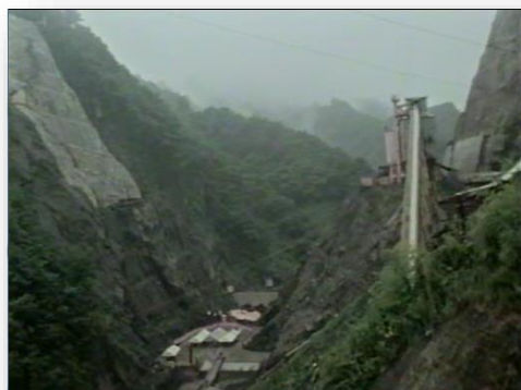
竜神ダムの建設が開始された竜神峡
