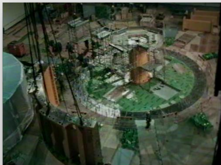
JT-60臨界プラズマ試験装置の据付工事
