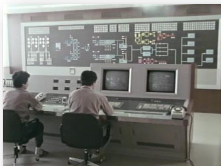
利根川浄水場
