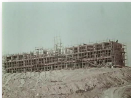
建設中の県立佐竹高校(常陸太田市)
