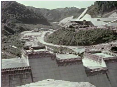
建設中の花貫ダム(高萩市)
