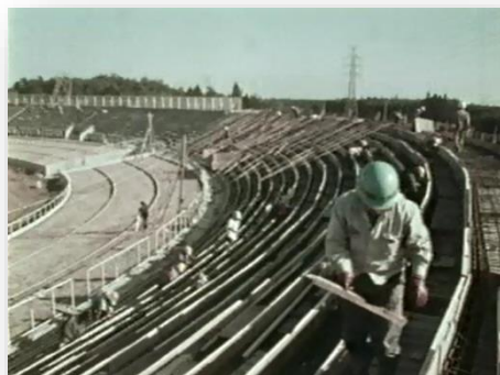
建設中の笠松運動公園陸上競技場
