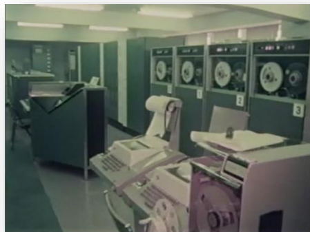
APMS鹿島実験センター
