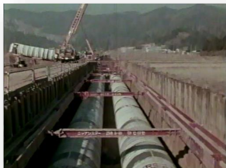
霞ヶ浦用水パイプ敷設(新治工区)
