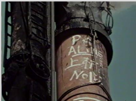
常磐自動車道建設工事
