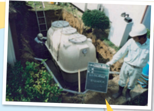
高度処理型浄化槽の設置補助
