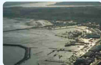
大洗港津波被害
