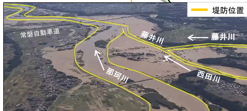
那珂川流域(水戸市, 那珂市, 城里町) 全壊:192棟, 半壊1,210棟, 一部損壊524棟
