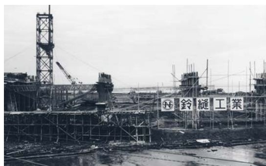
1964年 首都高速道路1号羽田線工事
