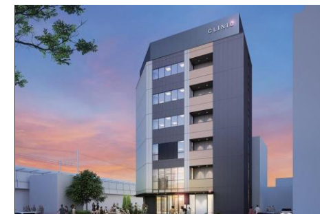
下総中山に建設中のテナントビル
