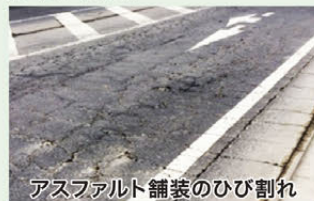
アスファルト舗装のひび割れ
