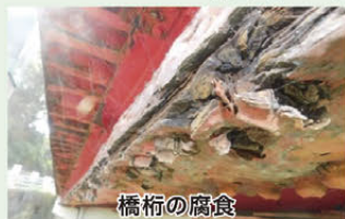
橋桁の腐食
