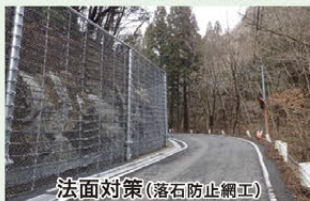
法面対策(落石防止網工)
