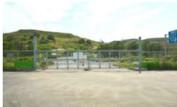
図-6-8.ストックヤードへ通じるゲート (南ふ頭内部より撮影)
