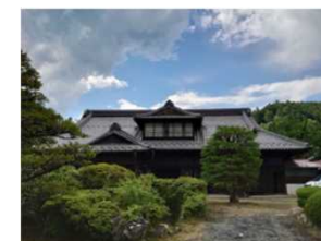
<2020年度>古民家改修モデルケース 大子町「旧成家住宅」
