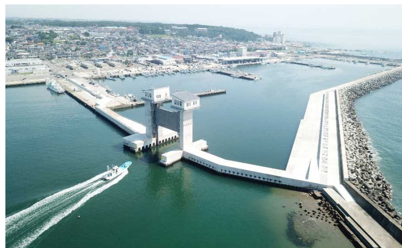
水門整備【大洗港区海岸】
