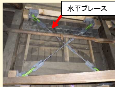
屋根裏 補強状況（水平ブレース設置）
