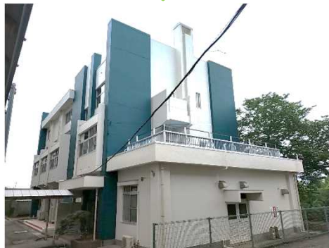
外壁塗装改修工事
