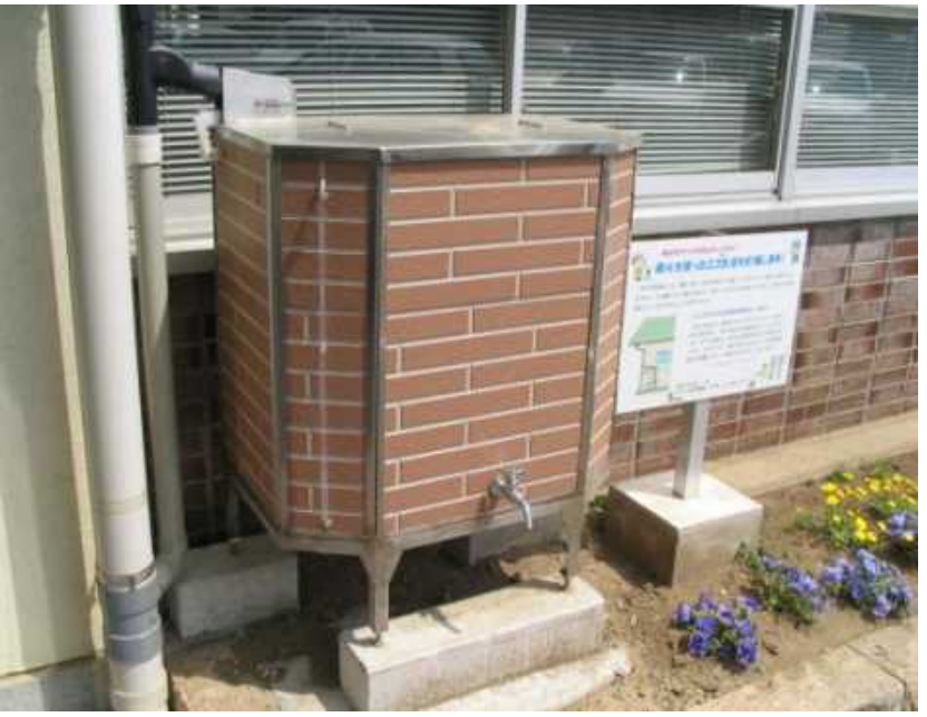
雨水貯留槽の設置イメージ
