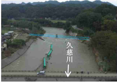
■令和元年10月洪水 (久慈川) (大子町南田気地内 JR橋)
