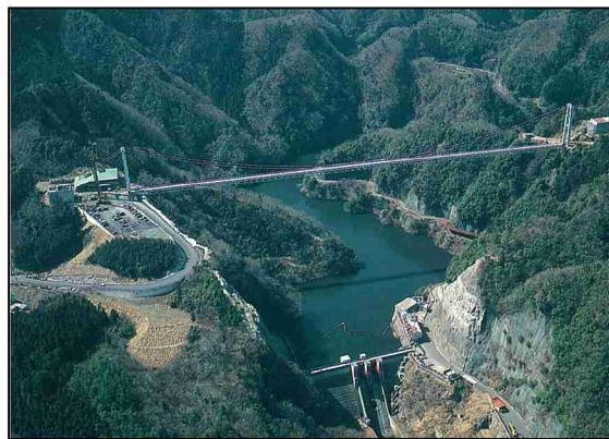
竜神ダム，竜神大吊橋
