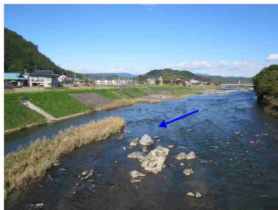
現況河床を残した久慈川の河道改修例 (左：松沼橋付近、右：久慈川橋付近)
