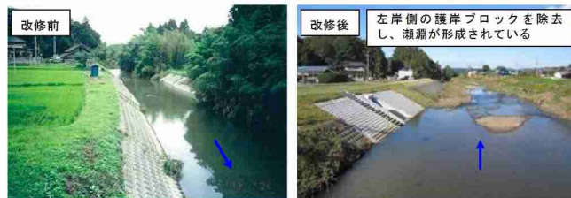
自然環境の保全・回復に配慮した浅川の改修例（善光寺橋付近）
