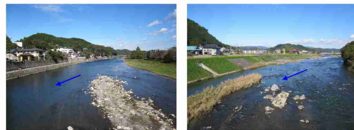
現況河床を残した久慈川の河道改修例 (左：松沼橋付近, 右：久慈川橋付近)
