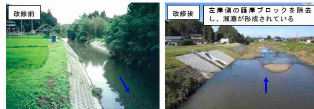
自然環境の保全・回復に配慮した浅川の改修例（善光寺橋付近）
