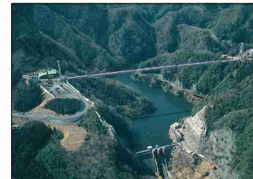
竜神ダム、竜神大吊橋
