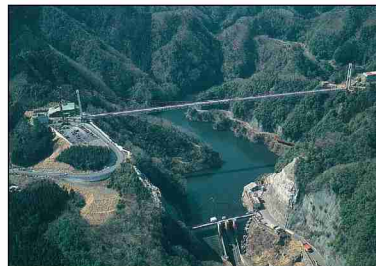
竜神ダム、竜神大吊橋
