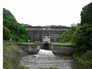
写真1-3 藤井川ダムの状況
