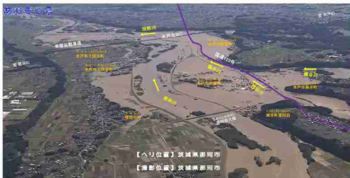
写真 1-3 令和元年東日本台風時の浸水状況 (国交省へり撮影)
