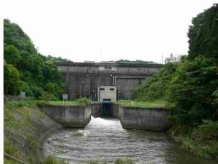
写真1-4 藤井川ダムの状況
