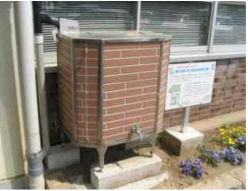
雨水貯留槽の設置イメージ
