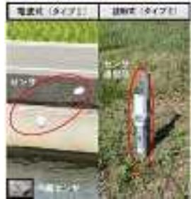
浸水センサの設置イメージ
