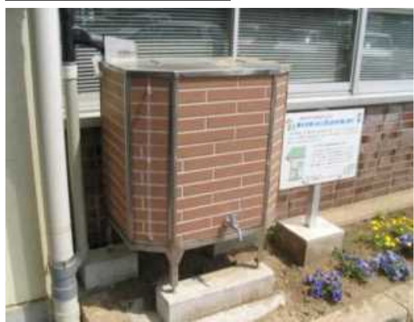
雨水貯留槽の設置イメージ
