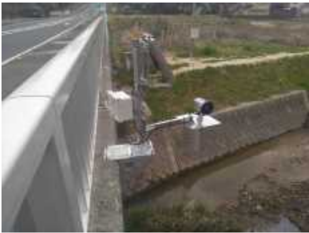
危機管理型水位計の設置イメージ
