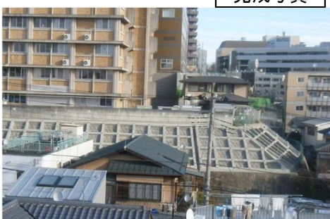
法枠工・鉄筋挿入工の完成
