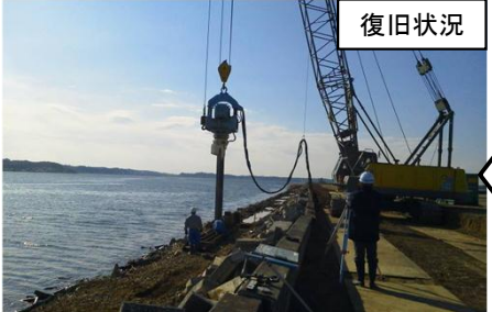
本復旧工事(鋼矢板の打設状況)
