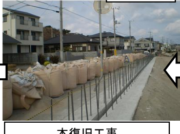
本復旧工事(コンクリート打設の準備状況)
