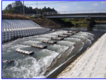
河川改修事業で整備した魚道
