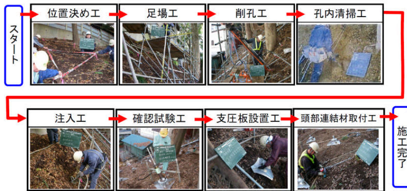
景観や環境の観点から、斜面の樹木保全が可能であるノンフレーム工法で施工いたしました。
