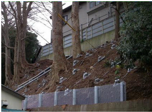
景観や環境の観点から、斜面の樹木保全が可能であるノンフレーム工法で施工いたしました。
