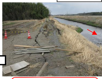
堤防が沈下し縦断方向に亀裂が発生
