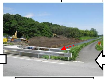
応急対策後 (堤防仮締切り工)
