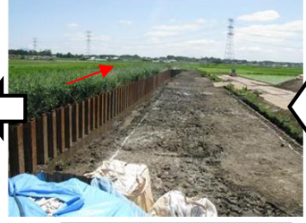
応急対策後 (堤防仮締切り工)
