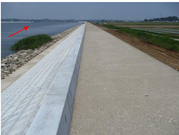
張りブロック(3.(4)) 計67,000m 2
