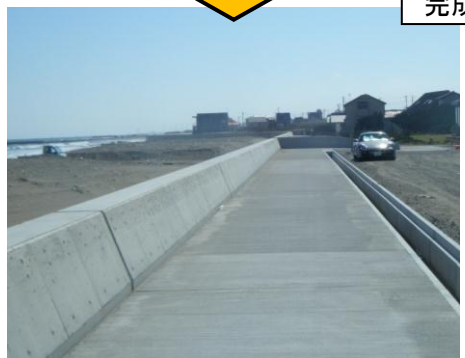
沈下し破損した堤防及び天端を元の高さに復旧しています。
