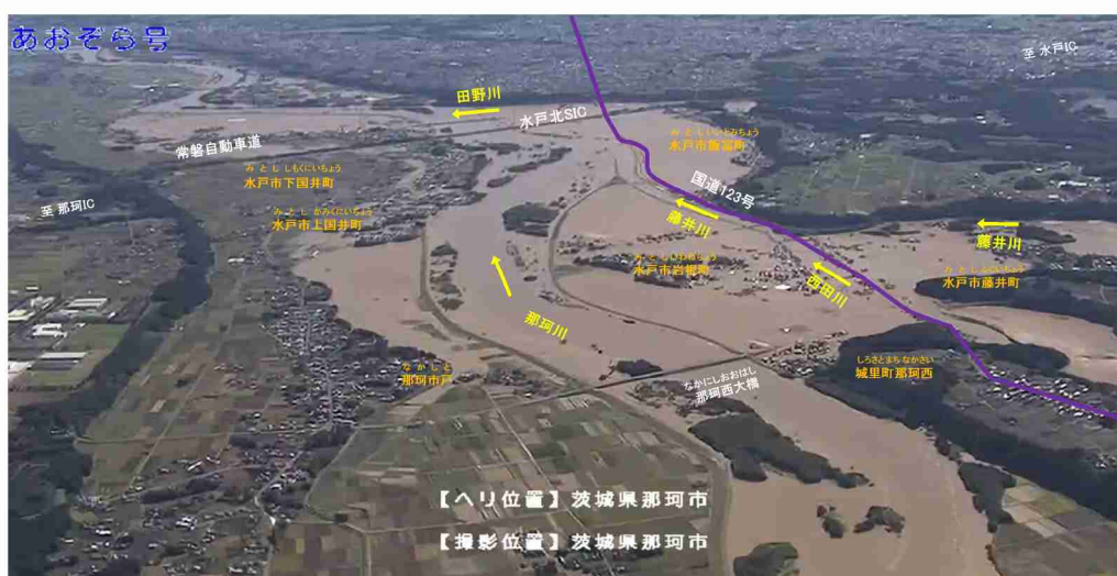
写真 1-3 令和元年東日本台風時の浸水状況 (国交省へり撮影)
