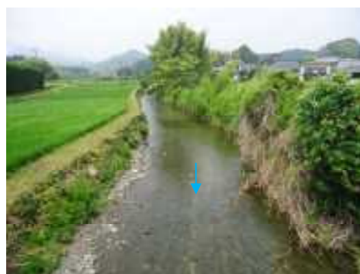
中流域（関本橋上流）
