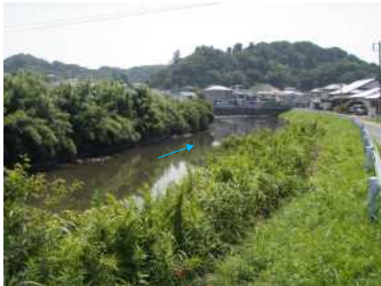
里根川現況河道の様子〔0.7 km付近〕
