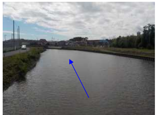
下流区間(新磯馴橋下流)
