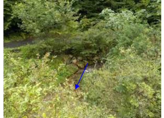
上流区間(上紅葉橋上流)
