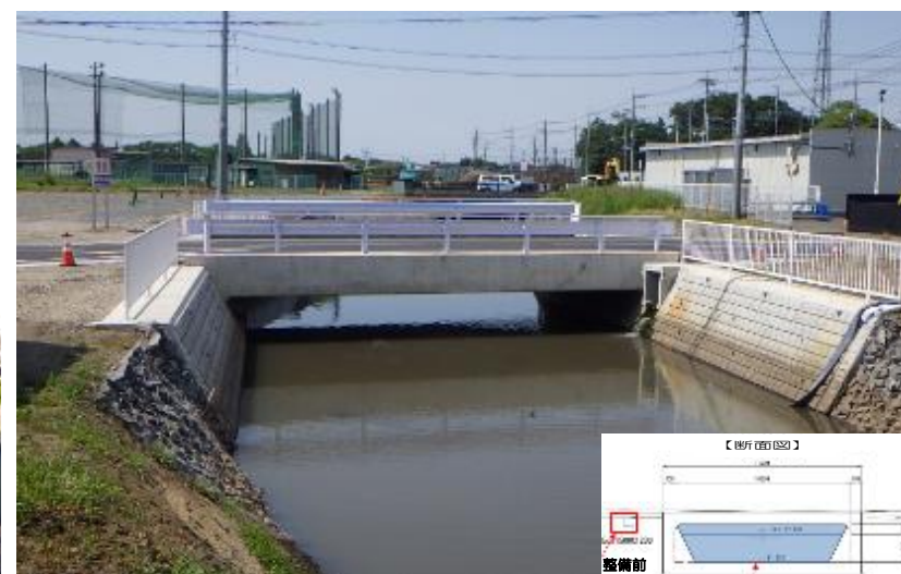
【下流側からの景況】
