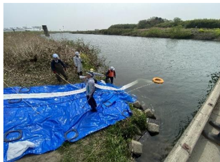
排水ポンプ投入
