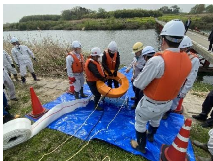
排水ポンプ投入
