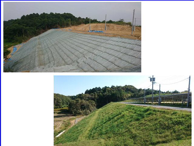
造成工事現場 (茨城県実績・民間工事)
