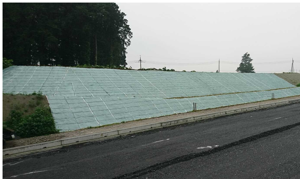
道路改良工事実績 (茨城県実績・上吉影岩間線)
