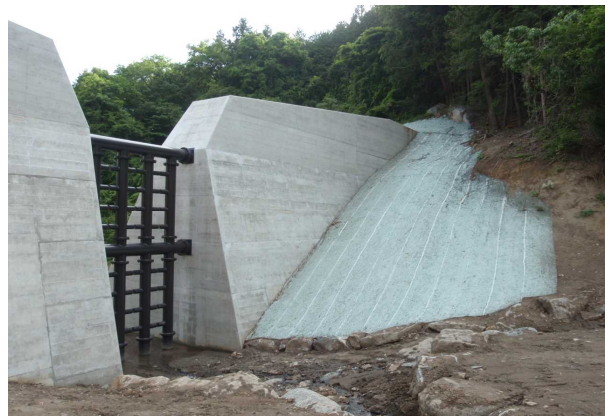
砂防堰堤現場
