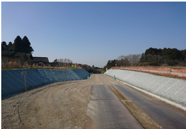
道路改良工事実績 (茨城県実績・四鹿地区改良)
