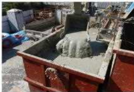
①泥土発生
