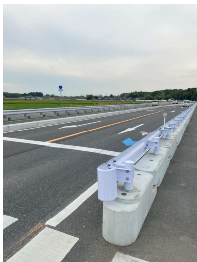
交差点改良舗装工事(その1)一般国道125号
