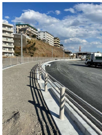
道路改良舗装工事 水戸駅平須線
