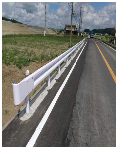
一般国道293号 道路災害復旧工事
