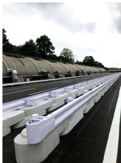
国総研試験走路改良舗装その他(その1)工事
