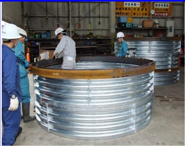
気中組立(止水パッキン無し)
