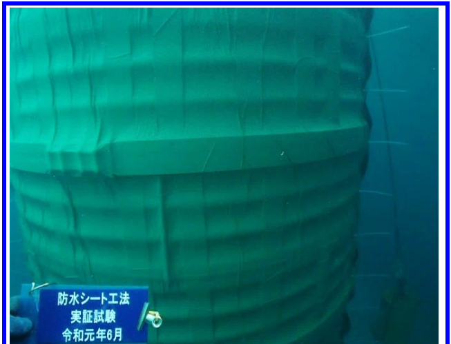
防水シート被覆完成後(水中)
