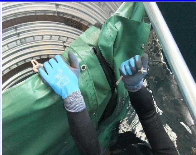
防水シート被覆作業(防水ファスナー引上げ)
