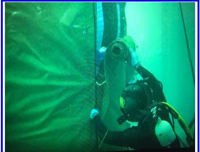
防水シート被覆作業(防水シート引上げ)
