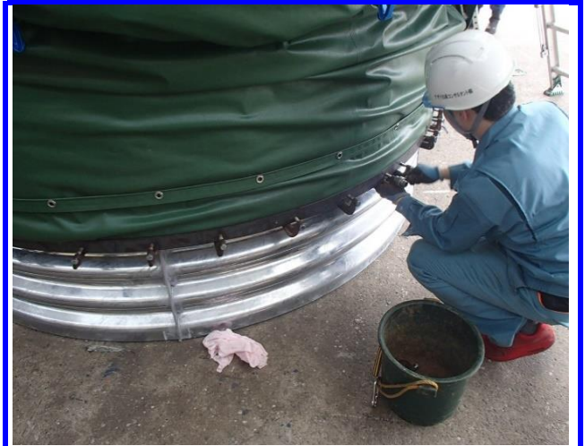
防水シート端部取付(止水処理)
