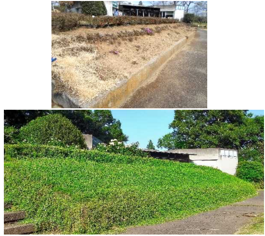
茨城県フラワーパーク(裸地法面緑化)
