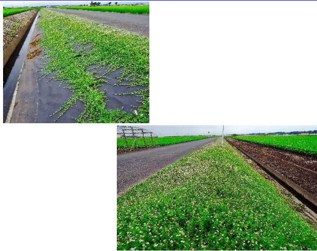
施工経過(成育中～全面繁茂・開花)
