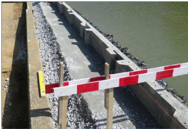
⑤笠石コンクリート構築準備
