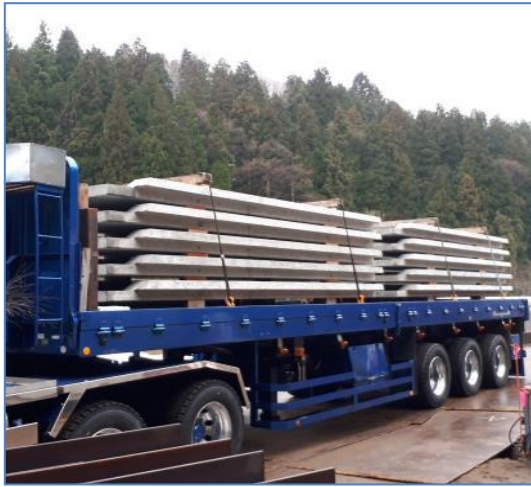
①コンクリート矢板の搬入
