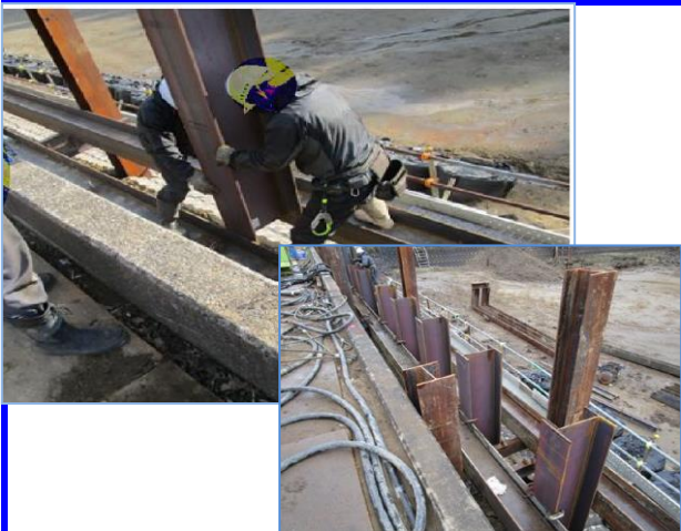
③H杭の打込み
