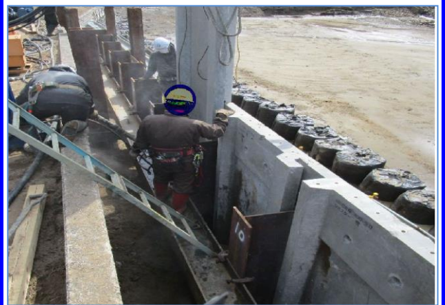
④コンクリート矢板の打込み
