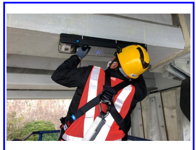
橋梁点検車による検査風景
