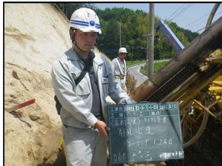
現場監督の状況
