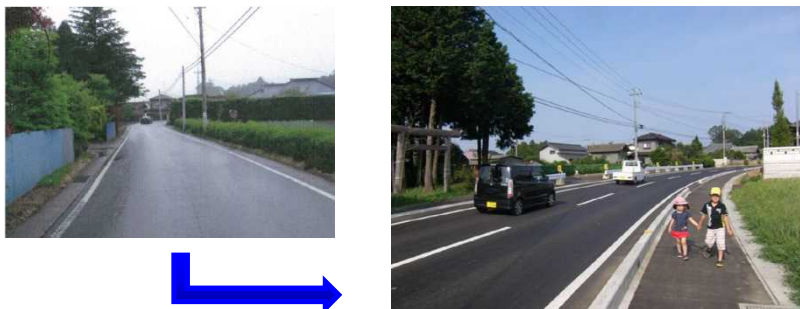
歩道整備による安全性の向上
