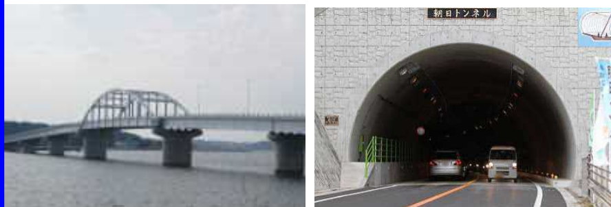
橋梁・トンネル整備により移動円滑化
