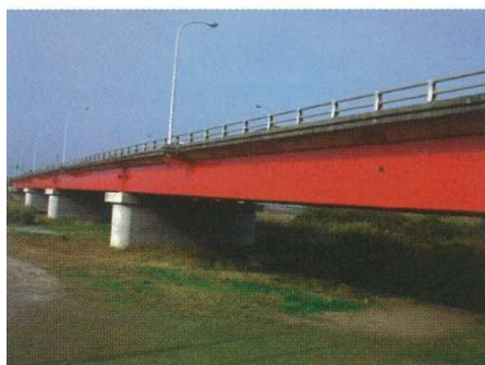
橋梁補修 (再塗装)
