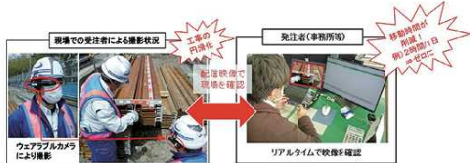
工事における遠隔臨場の実施
