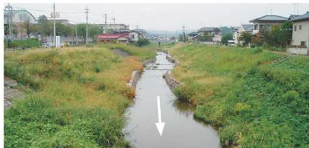
緩傾斜護岸や瀬、淵を設けるなど、多自然川づくりがなされている湧氏川（常陸太田市）
