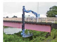
橋梁点検車による橋梁点検状況
