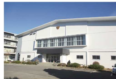
古河第一高校体育館長寿命化改修工事
