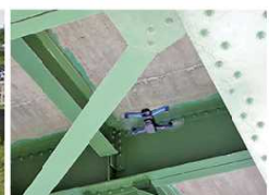
ドローンを活用した橋梁点検状況
