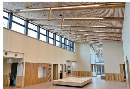
県産木材の利用 （あすなろの郷セーフティネット棟A 寮棟他新築工事）
