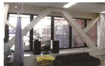
大規模な建築物の耐震改修（ブレース設置）事例
