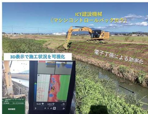
ICT建機による施工
