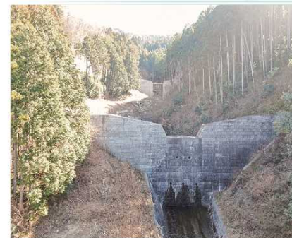
砂防事業（堰堤工）鉦柄平沢（常陸太田市）
