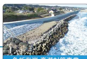
角折海岸 高潮対策事業 (鹿嶋市)
