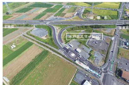
常磐自動車道（水戸北スマートIC） 令和元年9月7日 フルインターチェンジ供用
