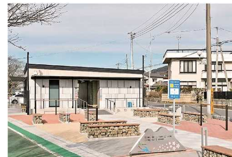
県産石材の利用 （りんりんロード筑波休憩所改築工事）
