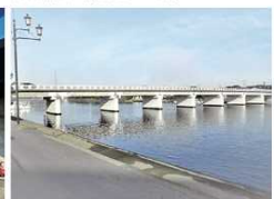
県道水戸鉾田佐原線 淵沼橋 (水戸市)
