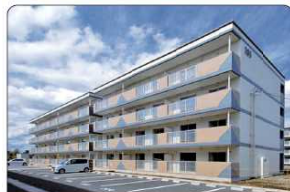
桜川西アパート(水戸市)
