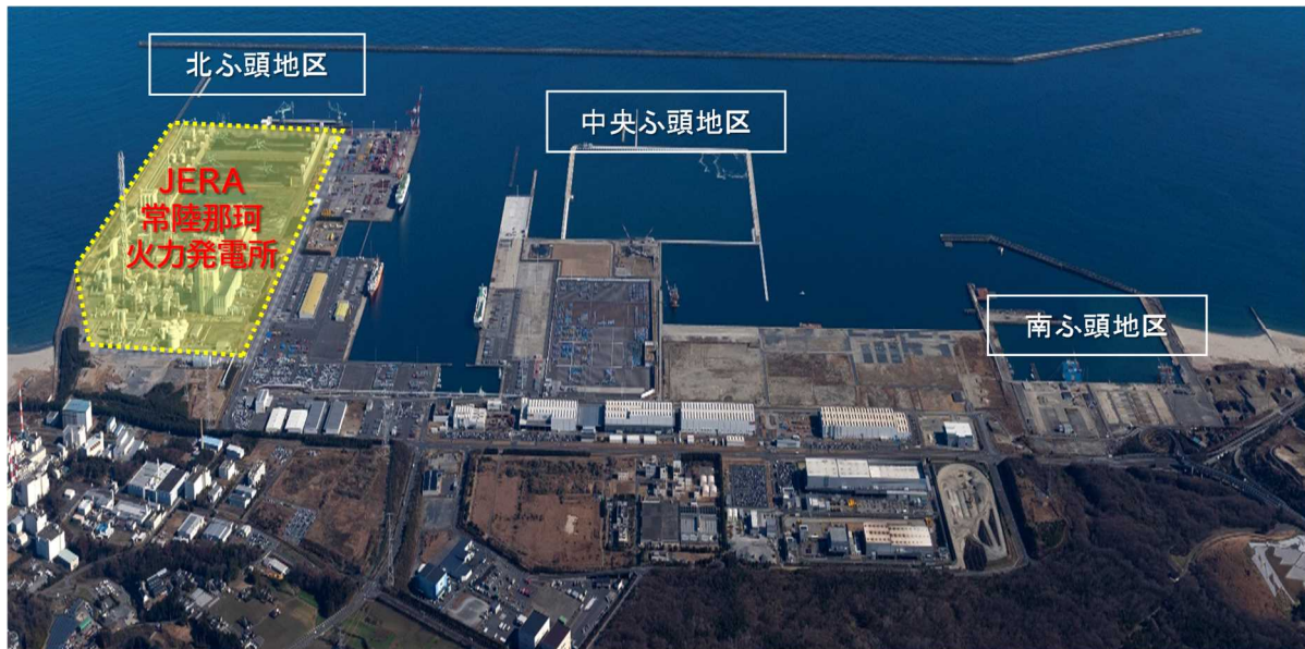
【常陸那珂火力発電所全体概要】
