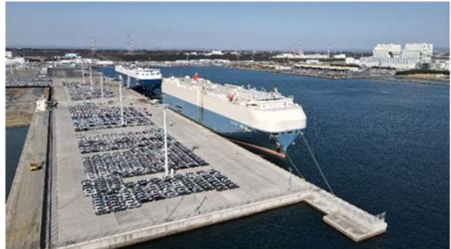
中央D岸壁(R5.3 月供用開始)
