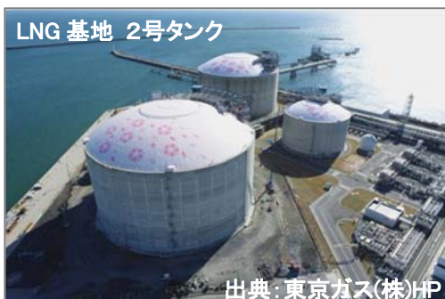
【日立LNG基地全体概要】
