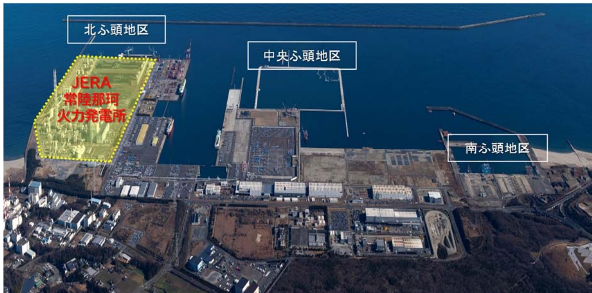
【常陸那珂火力発電所全体概要】
