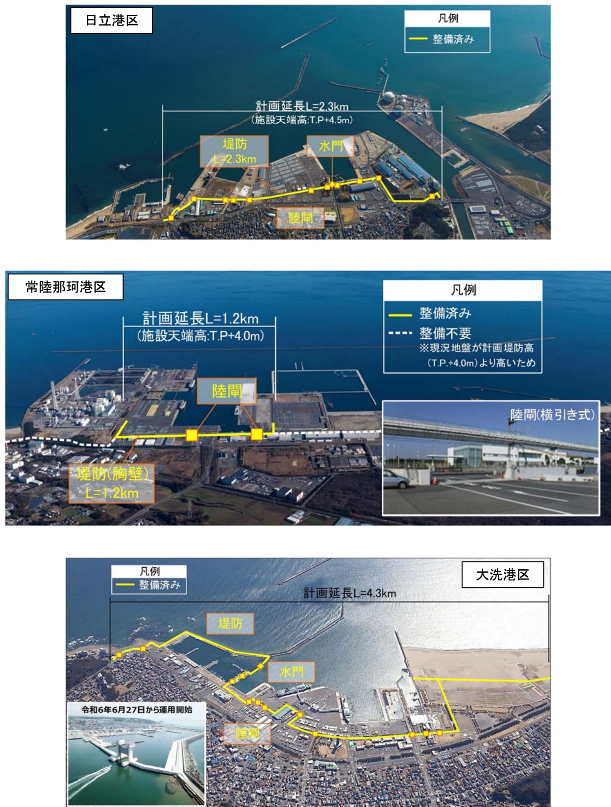
図3-14 海岸保全施設整備状況
