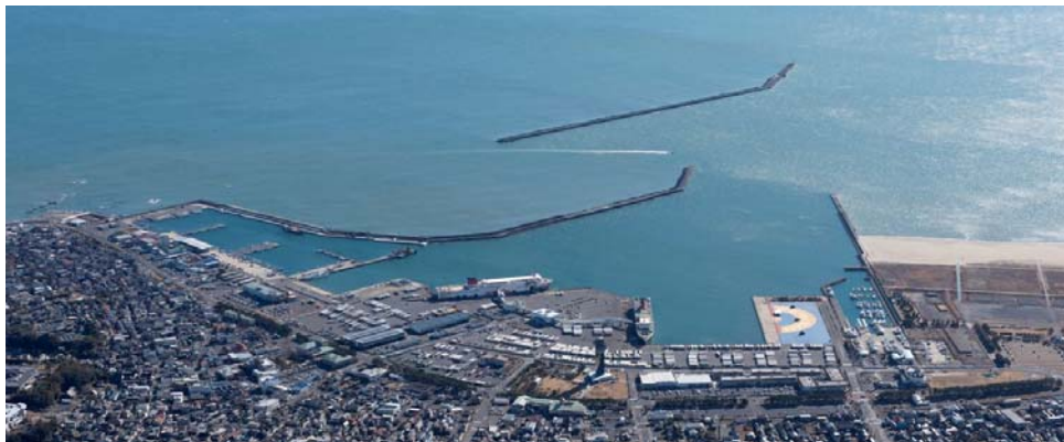
防波堤（大洗港区）
