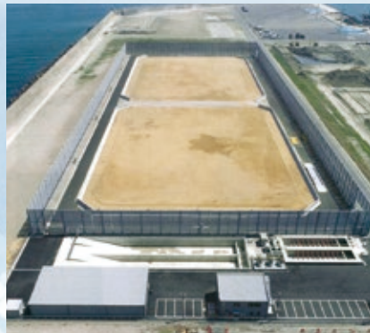
鹿島港外港公共埠頭貯炭場の全景
