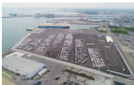
モータープールの様子
