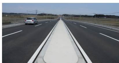
「土木部長表彰」 道路改良舗装工事 一般国道245号 (株)中島工務店
