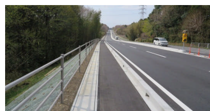
「土木部長表彰」 道路改良舗装工事 一般国道349号 (株)鶴田組
