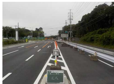
「土木部長表彰」 道路改良舗装工事(その2) 一般国道245号 橋本建設(株)
