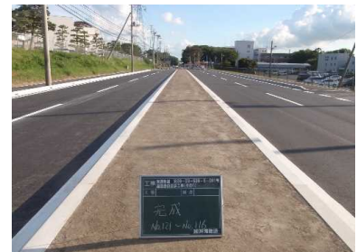
「土木部長表彰」 道路改良舗装工事(その1) 一般国道245号 (株)井滝建設
