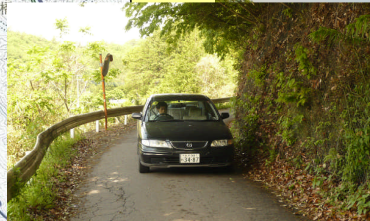
狭隘で屈曲している現況道路
